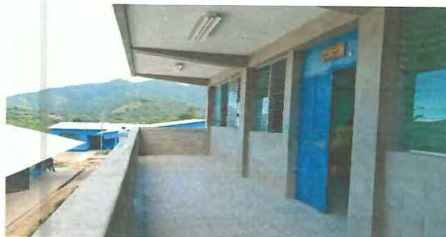
Foto1: CAMBIO DE VENTANALES DE PALETA POR VENTANALES DE PVC, Y SUMINISTRO DE BALCONES, EN EL AULA PARA TERCERO BÁSICO.
