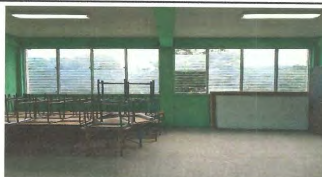
Foto 4: SUMINISTRO DE VENTANALES Y BALCONES PARA EL AULA DE PRIMERO BÁSICO, VISTA INTERIOR, LADO SUR
