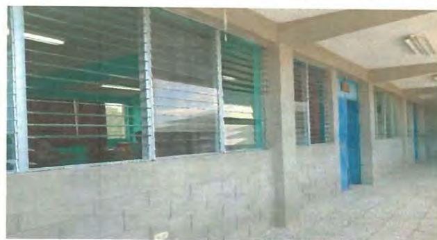
Foto 2: SUMINISTRO DE VENTANALES Y BALCONES PARA EL AULA DE TERCERO BÁSICO, VISTA EXTERIOR.
