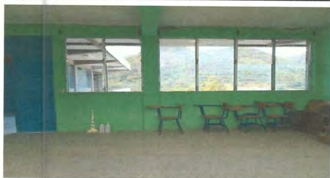
Foto 3: SUMINISTRO DE VENTANALES Y BALCONES PARA EL AULA DE PRIMERO BÁSICO, VISTA INTERIOR LADO NORTE.
